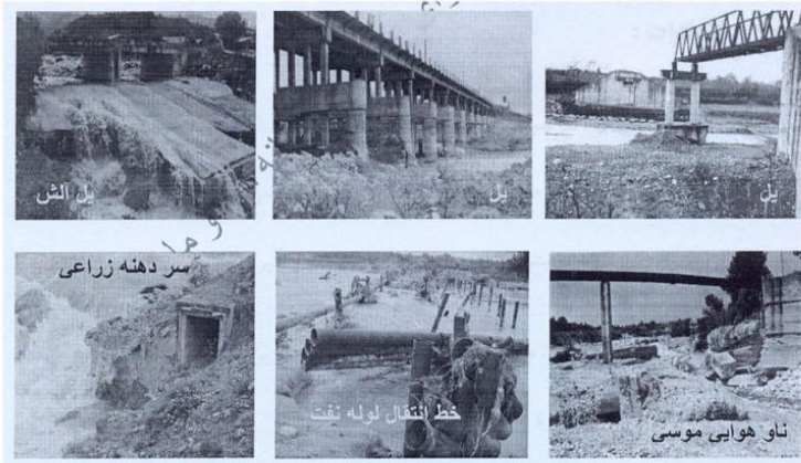
عکس شماره ۳- نمونه های دیگری از آثار برداشت بی رویه مصالح رودخانه ای بر سازه ها ،تاسیسات تقاطعی با رودخانه های استان مازندران
