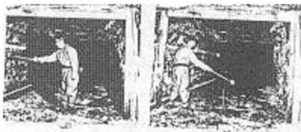
شکل ۳: نحوه اندازه گیری سرعت متوسط با تغییر مکان بادسنج [۱]
