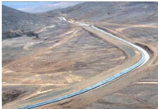
شکل (۱) استفاده از پوشش ژئوممبران در کانال
